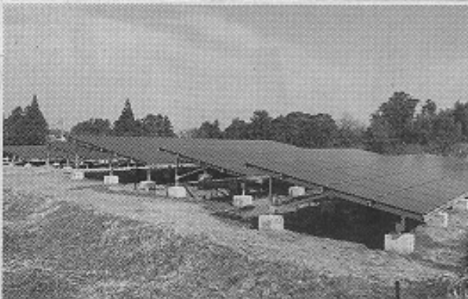
エコスマイルが手がけた最新の太陽光発電設備
