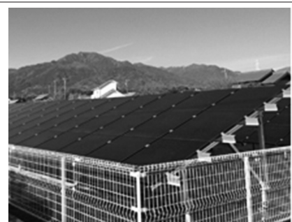
▲太陽光発電システムの施工事例
